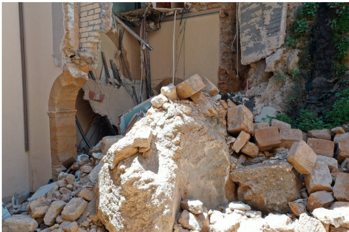
Figura 2.6: Corte inferiore - sopralluogo 30/07/2025
