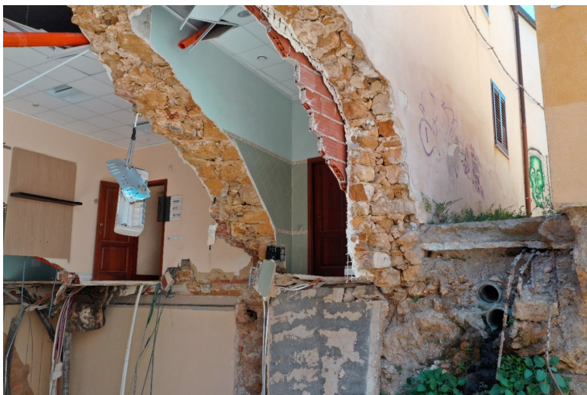
Figura 2.8: Immobile destinato ad alloggi - sopralluogo 30/07/2025
