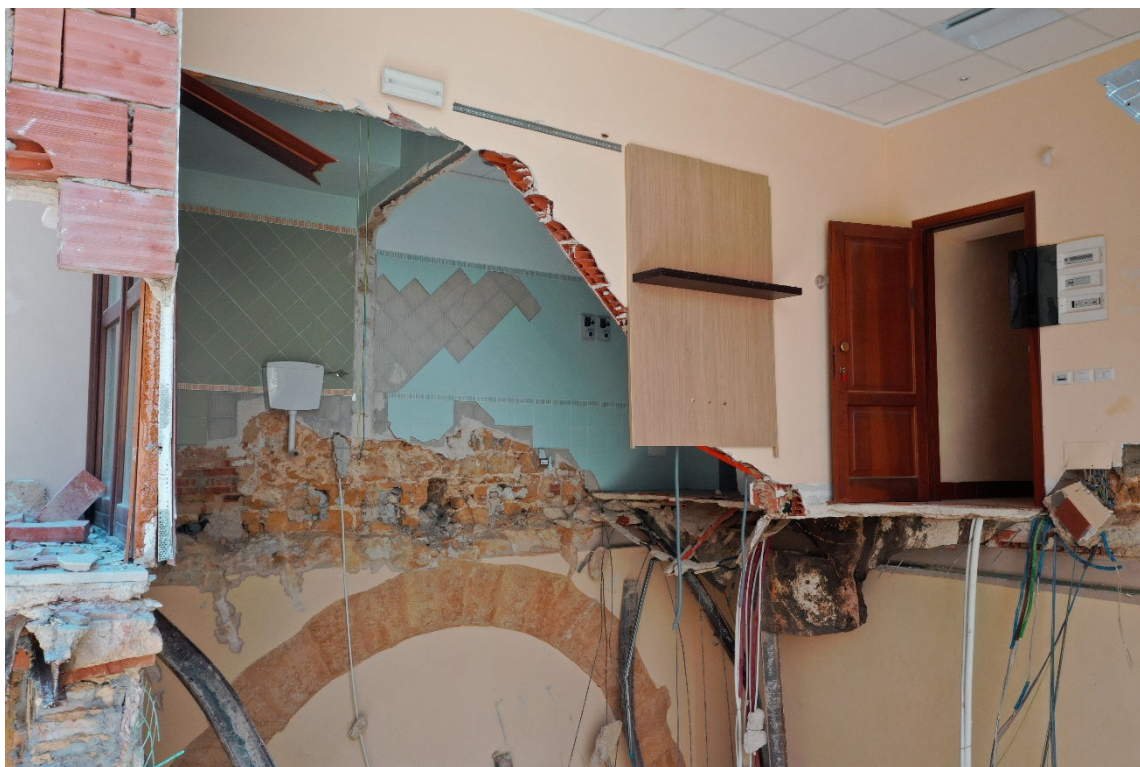
Figura 2.9: Immobile destinato ad alloggi - sopralluogo 30/07/2025
