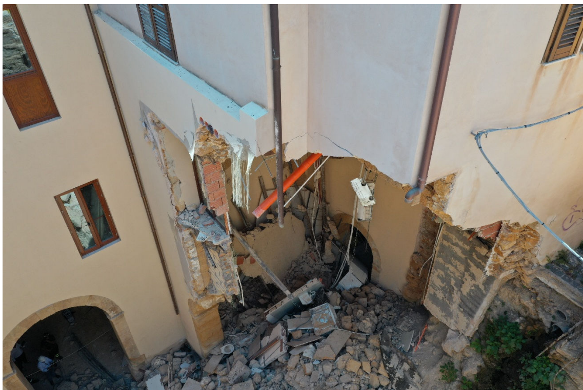
Figura 2.3: Corte inferiore - sopralluogo 30/07/2025
