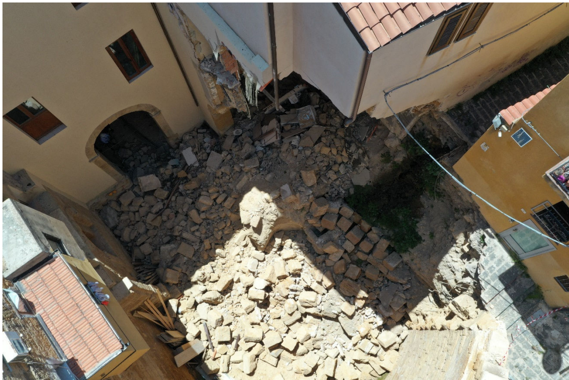
Figura 2.2: Corte inferiore - sopralluogo 30/07/2025
