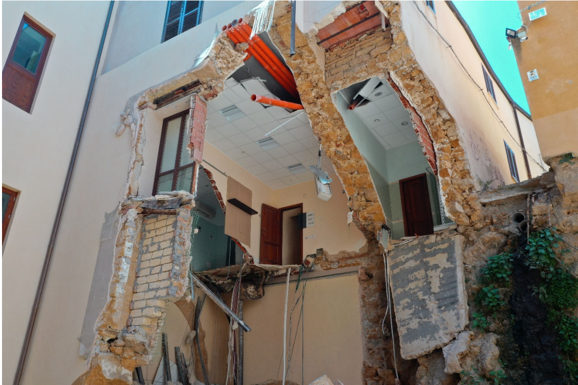
Figura 2.5: Corte inferiore - sopralluogo 30/07/2025
