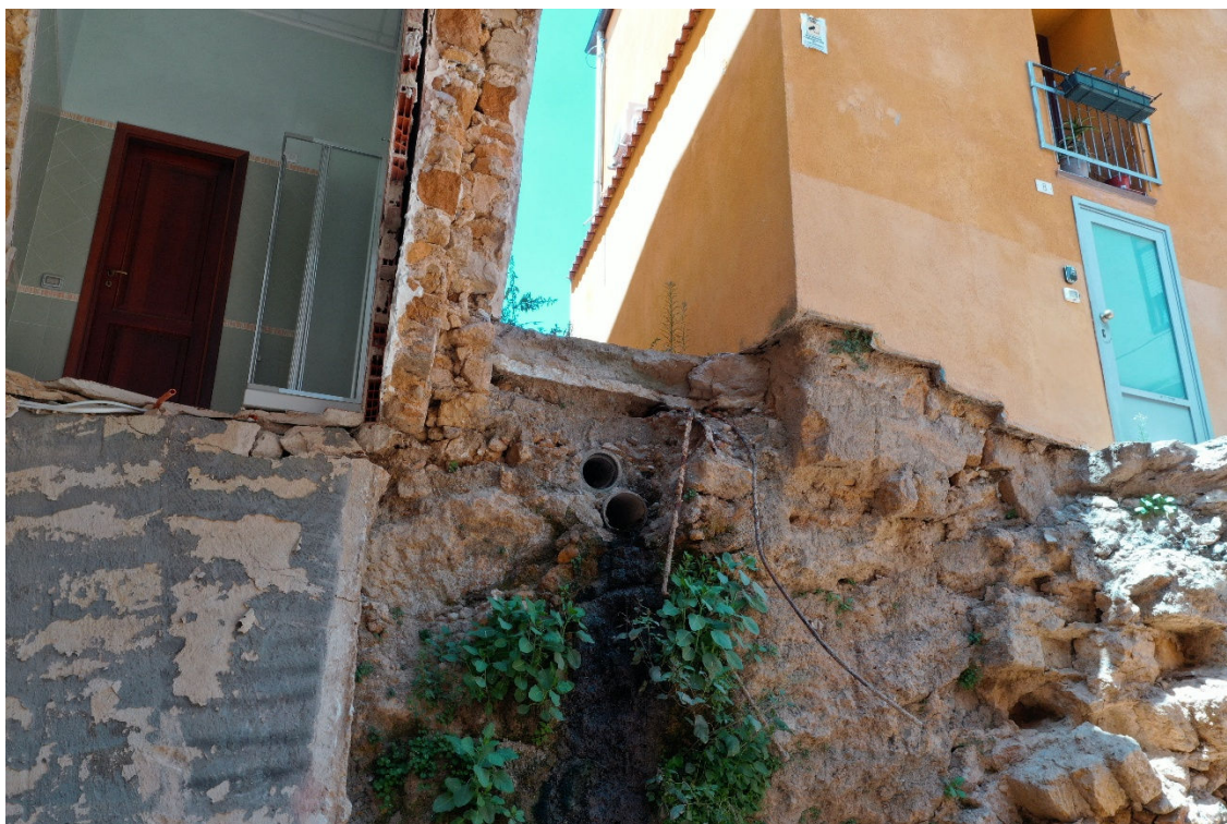
Figura 2.7: -Corte inferiore - sopralluogo 30/07/2025
