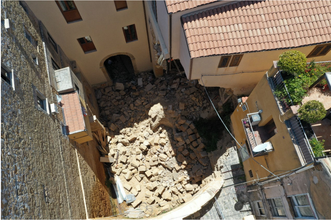
Figura 2.1: Corte inferiore - sopralluogo 30/07/2025
