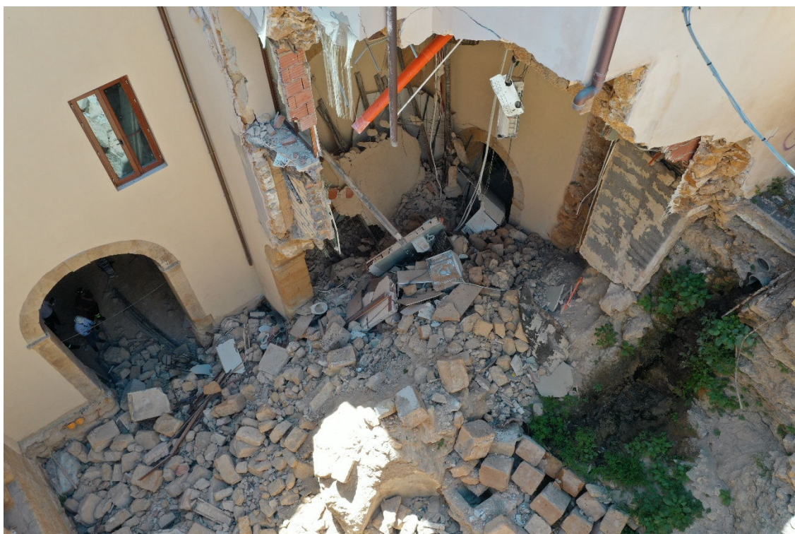
Figura 2.4: Corte inferiore - sopralluogo 30/07/2025
